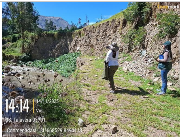
IMAGEN 02: SE OBSERVA LA ERSION EN LA AMRGEN DERECHA REQUIERE MANTENIMIENTO Y PROTECCION
