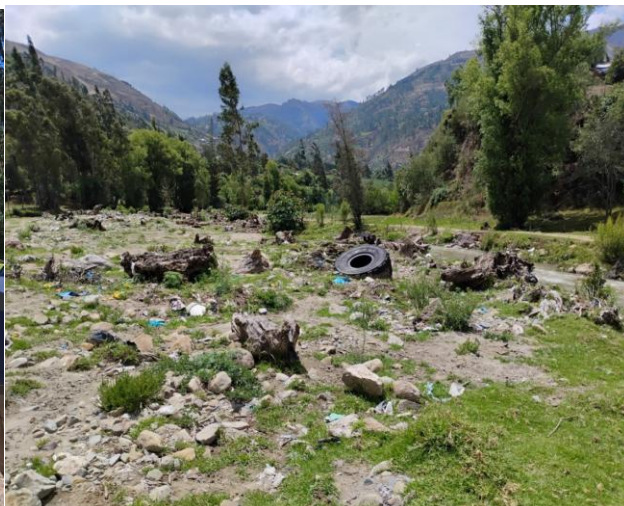
IMAGEN 04: SE OBSERVA LA COLMATACION DEJADA POR LA INUNDACION LO QUE SE REQUIERE DE LIMPIEZA Y DESCOLMTAACION DEL RIO CHUMBAO
